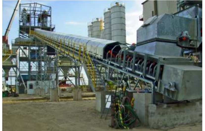
Transportador de correia com cobertura
