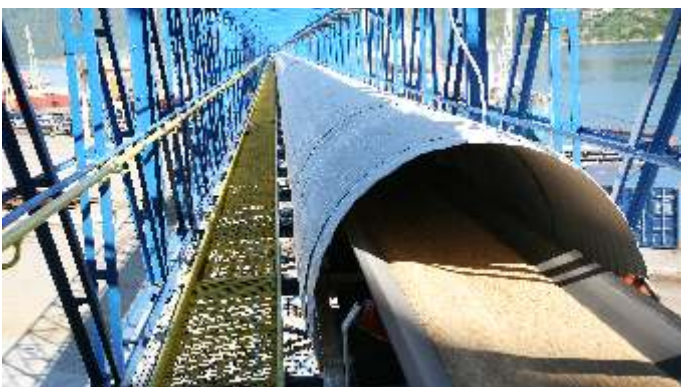
Transportador de correia em passarela metálica
